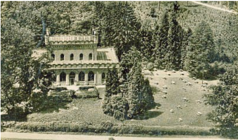
Das Gotische Haus um 1930. Auf der Wiese, wo Tische und Stühle (keine Schafe!) stehen, sind jetzt die Hochhäuser. FOTO: STADTARCHIV
