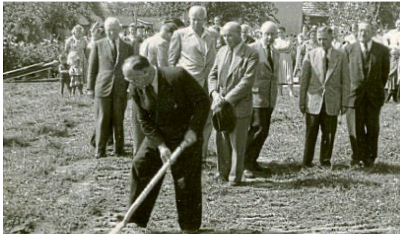
Am 12. August 1953 setzte Dornholzhausens Bürgermeister Ottmar Hiller den ersten Spatenstich. FOTOS (2): GESCHICHTSKREIS
